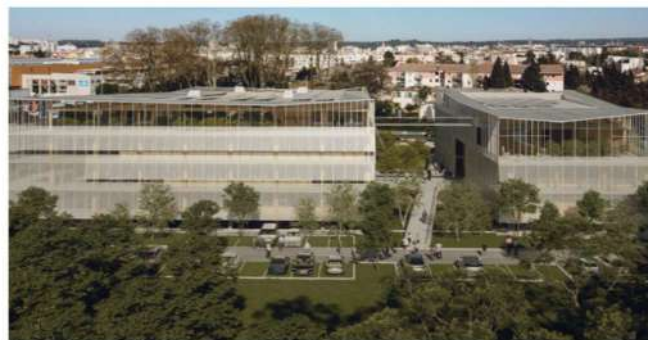
La Maison de l'entreprise sera terminée en fin d'année mise en service dans la foulée. • Photo CCI Gard
